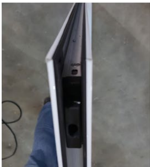
Foto 3 – Tiras de compósito elastomérico presentes nas travessas e no montante lateral.
