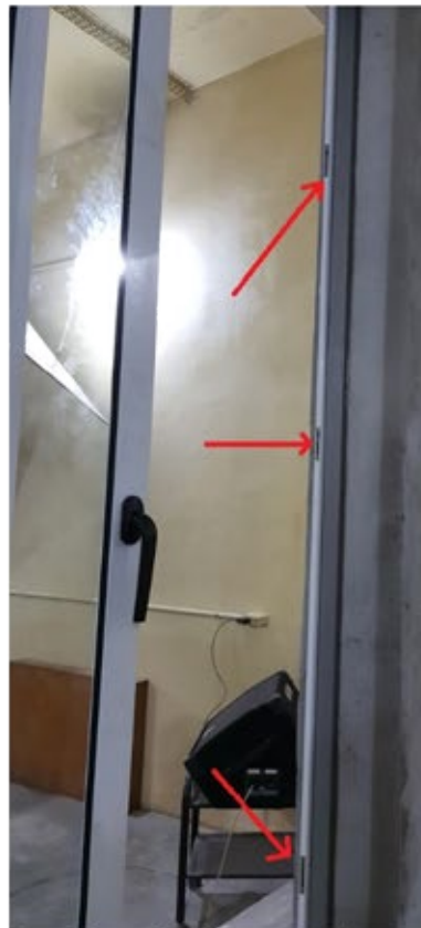
Foto 6 – Contrafechos com três pontos de travamento no marco.
