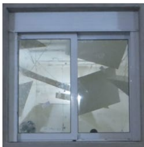
Figura 4 – Janela vista da câmara de emissão.
