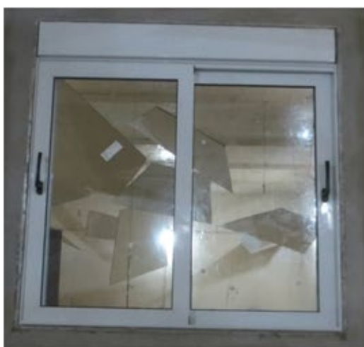
Figura 3 – Janela vista da câmara de recepção.
