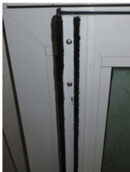
Figura 6 – Escovas presentes no montante central da folha em contato com o montante central da folha adjacente.
