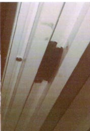
Foto 4 – Manta de composto plástico coberta por aparato plástico presente na travessa superior do marco.
