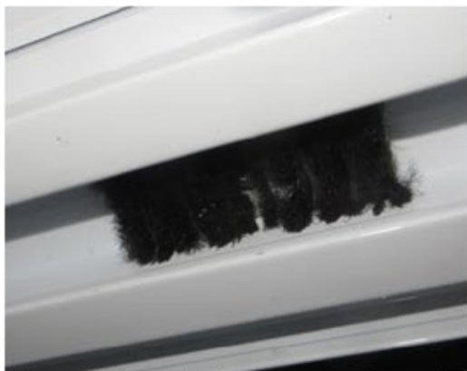
Figura 9 – Segmento de escova presente a meia largura da travessa superior.
