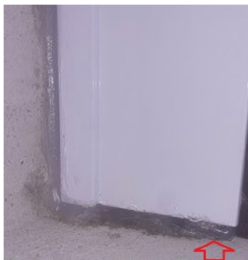
Figura 10 – Silicone aplicado nas juntas entre a janela e o vão de alvenaria.
