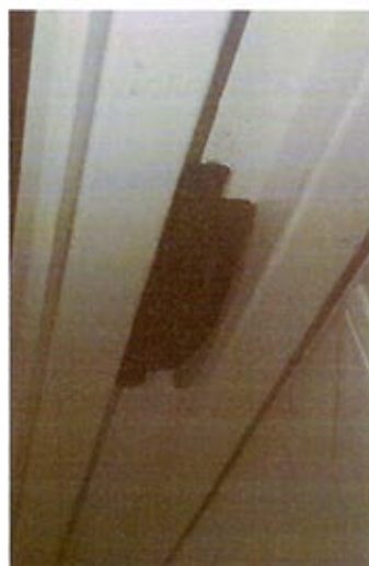
Foto 4 – Manta de compósito plástico coberta por aparato plástico presente na travessa superior do marco.
