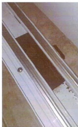
Foto 3 – Manta de compósito plástico presente na travessa inferior do marco.
