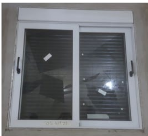
Figura 3 – Janela vista da câmara de recepção.
