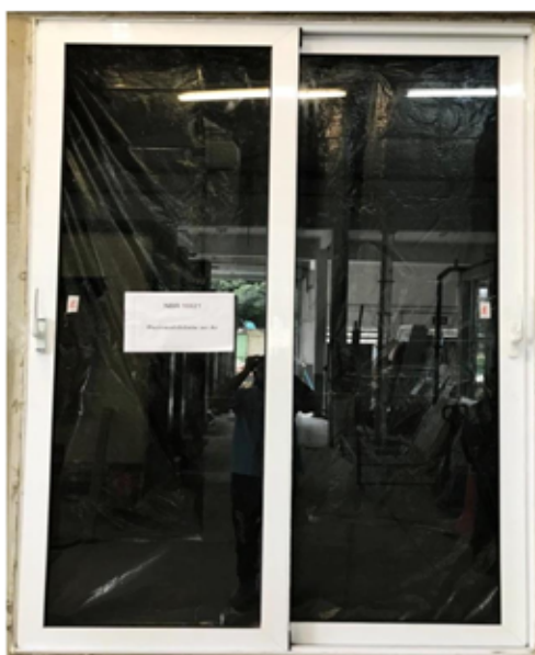
Foto n.º 01 – Visualização do ensaio de permeabilidade ao ar.
