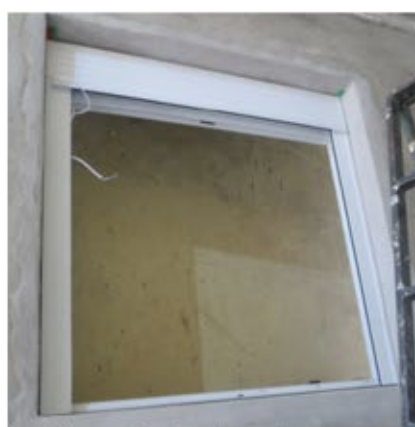
Figura 2 – Instalação do marco.
