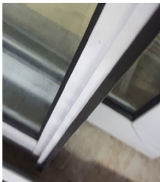
Foto 4 – Tira de compósito elastomérico presente no montante central da folha.
