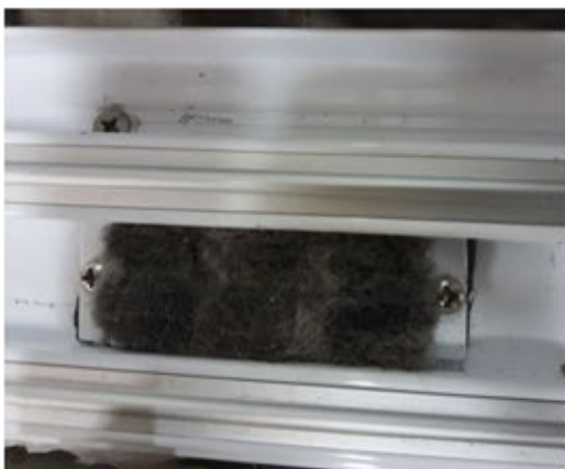
Foto 7 – Segmento de escova sobre aparato de composto elastomérico presente à meia largura do marco.
