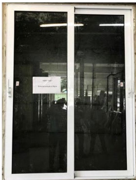
Foto n.º 02 – Visualização do ensaio de estanqueidade à água
