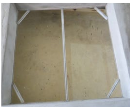
Figura 1 – Chumbagem do contramarco
