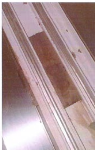
Foto 3 – Manta de composto plástico presente na travessa inferior do marco.
