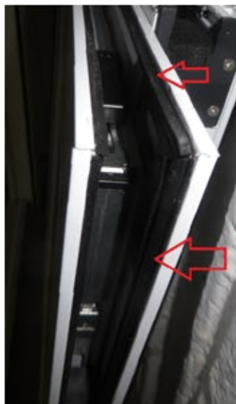
Figura 5 – Tiras de compósito elastomérico presentes nos montantes laterais e travessas da folha.
