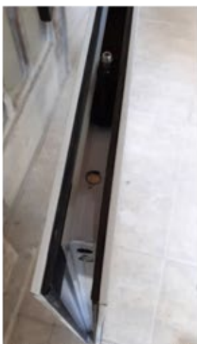
Foto 5 – Tiras de composto elastomérico presentes nos montantes laterais das folhas.
