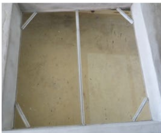
Figura 1 – Chumbagem do contramarco
