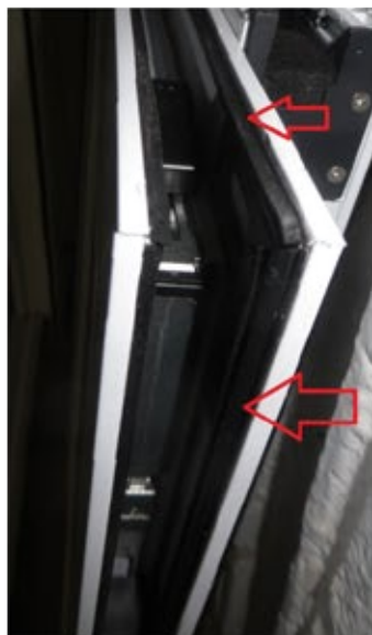
Figura 5 – Tiras de composto elastomérico presentes nos montantes laterais e travessas da folha.
