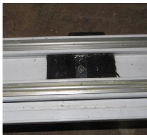
Figura 8 – Segmento de escova presente a meia largura da travessa inferior.
