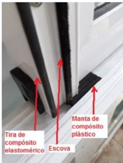
Foto 3 – Escova e tira de composto elastomérico presentes nos montantes centrais das folhas e segmento de manta de composto plástico a meia largura das travessas do marco.
