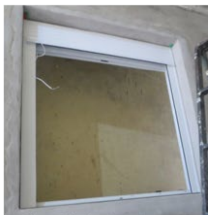
Figura 2 – Instalação do marco.
