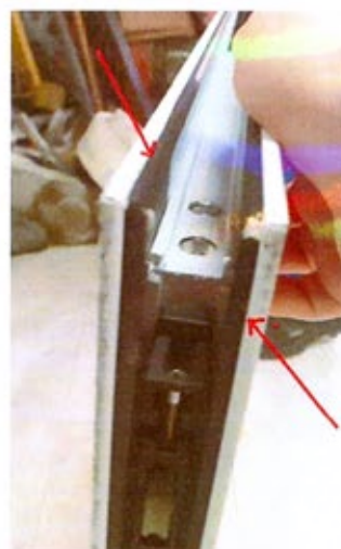
Foto 5 – Tiras de composto elastomérico nos montantes e travessas da folha e roldana presente na travessa inferior.
