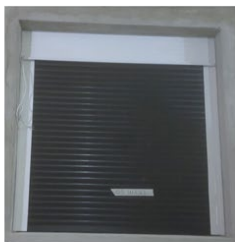
Figura 4 – Janela vista da câmara de emissão.
