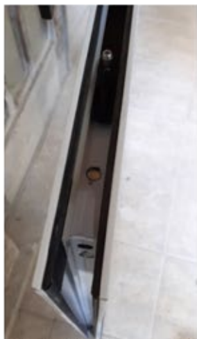
Foto 5 – Tiras de compósito elastomérico presentes nos montantes laterais das folhas.
